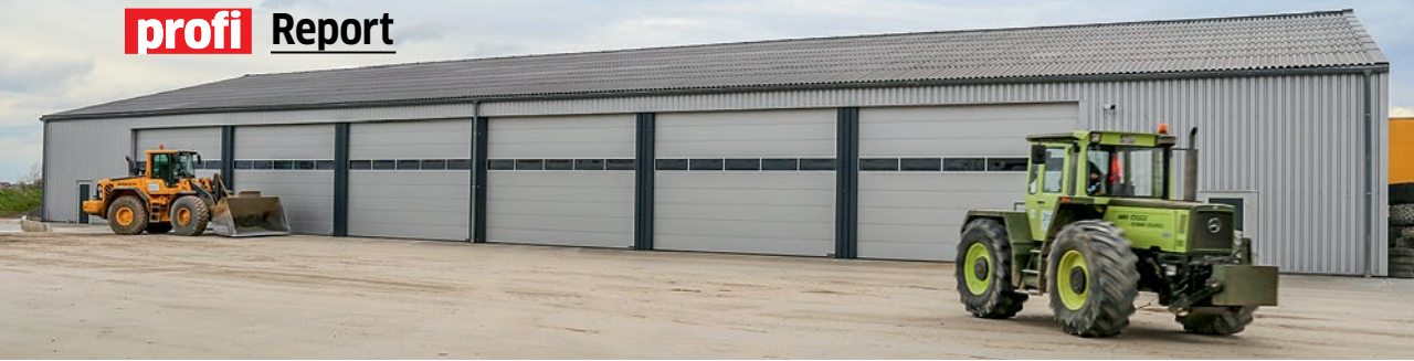
Viel Platz: Auf dem 2013 neu gebauten Betriebshof bieten drei große Hallen reichlich Unterstellmöglichkeiten.
